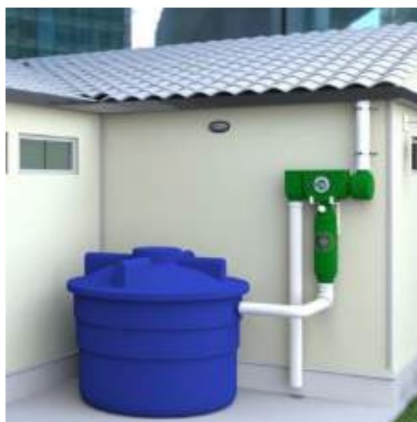
Рис 28. Система для збору дощової води, https://cikavosti.com/sistema-zboru-doshhovoyi-vodi-dlya-vikoristannya-u-yakosti-pitnoyi-vodi/#google_vignette
